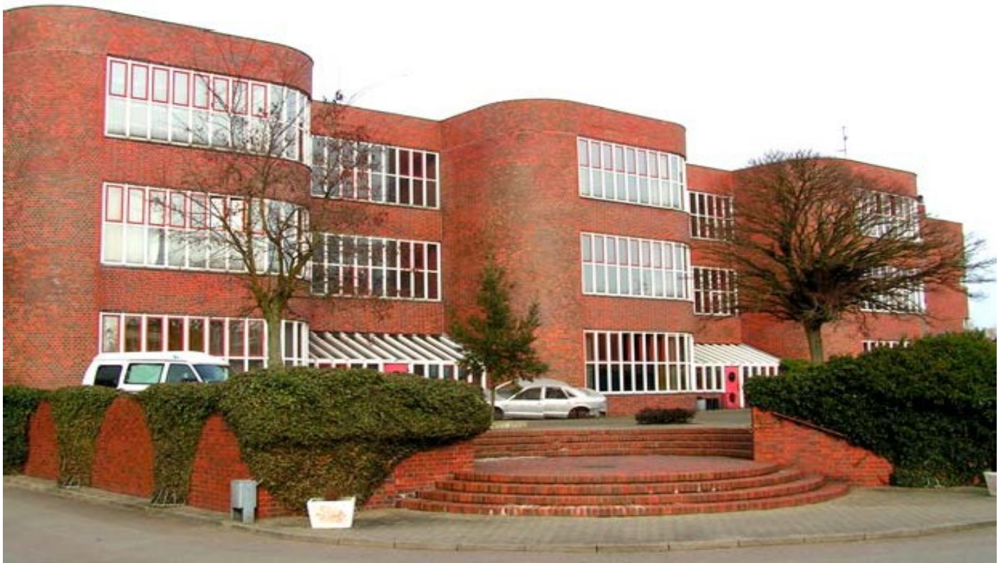
Blick auf das Gebäude mit den Unterrichtsräumen, Laboren und die überbetrieblichen Werkstätten auf dem Priwall
